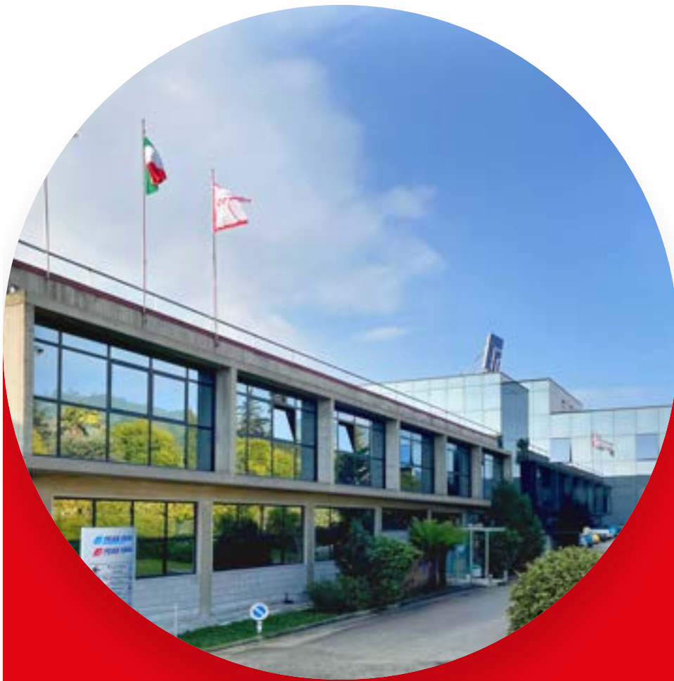
Frigo Tecnica Internazionale 📍 Italia
